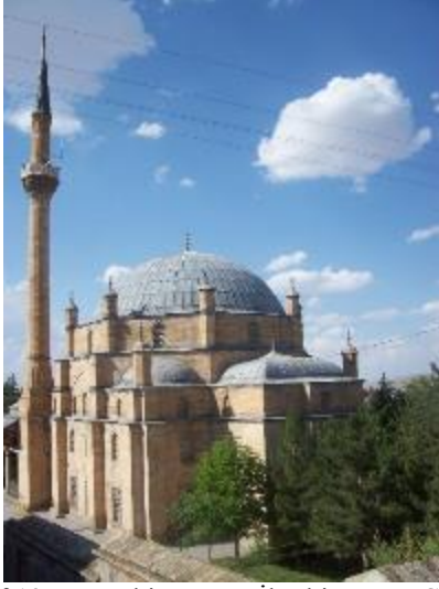
Fotoğraf 13: Nevşehir Damat İbrahim Paşa Camii (Vakıflar Genel Müdürlüğü'nden)
