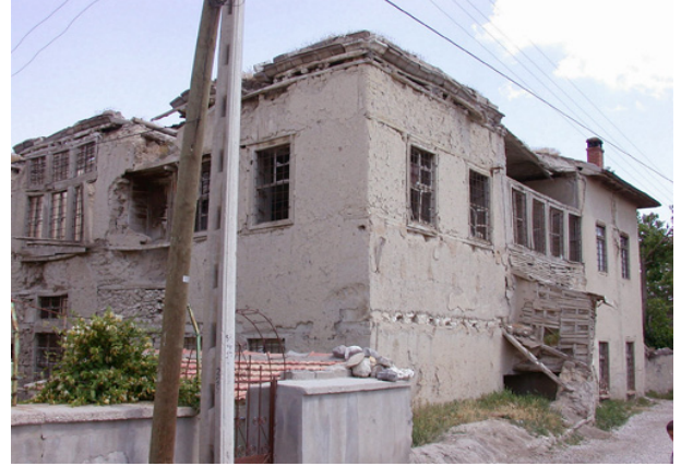
Şekil 1: Tartan Evi Restore Edilmemiş Hali
