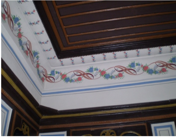
Şekil 8: Tartan Evi İç Mekan Kaynak: Gülşen KAHRAMAN
