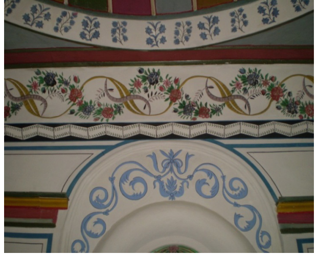
Şekil 6: Tartan Evi İç Mekan Kaynak: Gülşen KAHRAMAN
