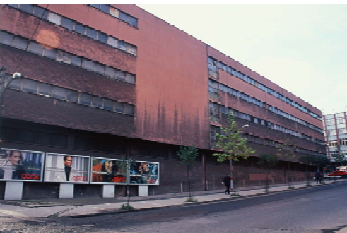
Şekil 20. Kuzey cephesi (2004) (North elevation-2004)
