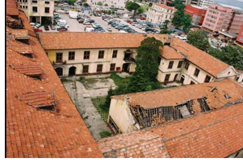
Şekil 2. A-B blok iç avlu [11] (Interior court of A-B block)
