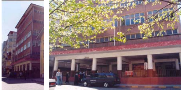
Şekil 29. 4. Blok kuzey cephesi (The north elevation of 4 th block)
