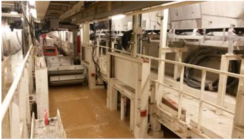
Resim 2 - Silvan tüneli kazısı sırasında karşılaşılan su çıkışı
