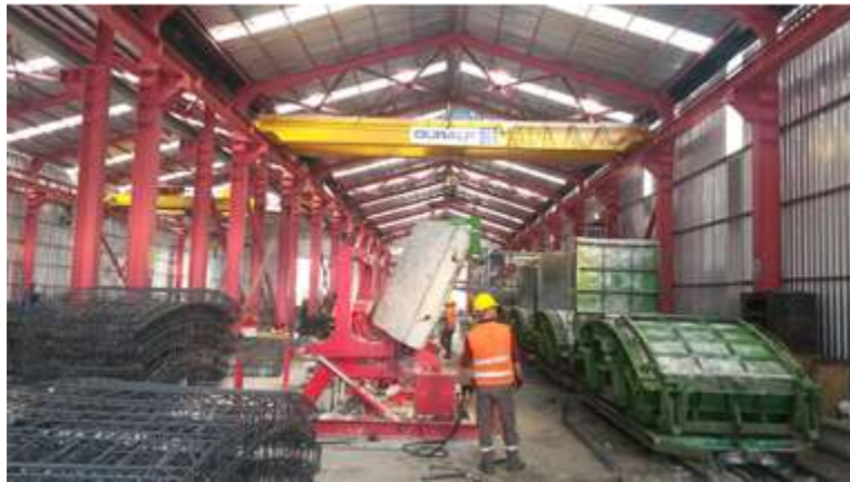
Resim 6 - Segment fabrikası, segment donatısı ve kalıbı
