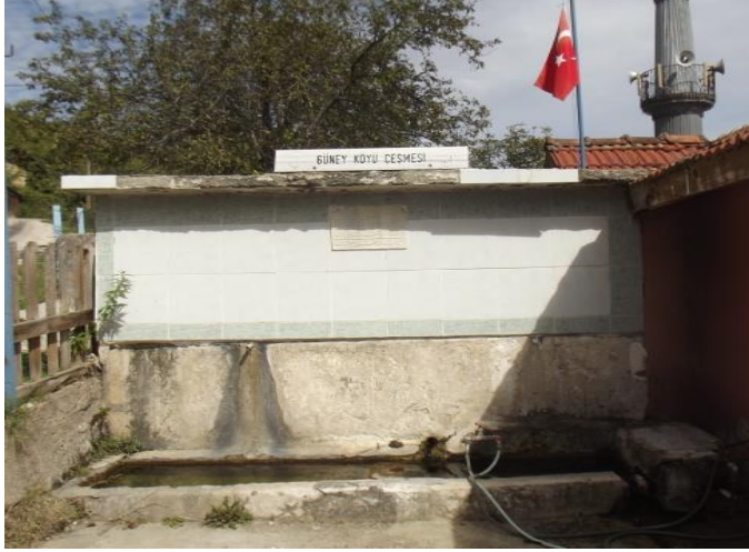
Fotoğraf 7: Güney Köyü Çeşmesi Genel Görünüm
