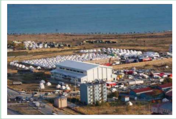
Şekil 1. Van Erciş Yenişehir Stadyumu Çadırkenti (URL-5).
