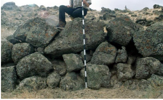
Resim 5. Sur Duvarları Detay
