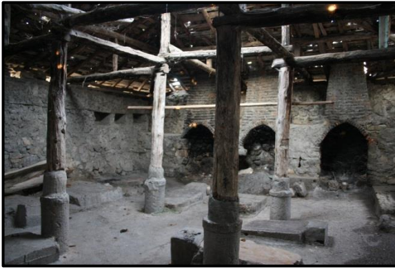
Foto 5. Adatepe Mahallesi çamaşırlığı.
