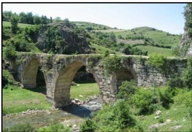
Foto 1. Restorasyon öncesi tarihi Kurtköprü'ye güneydoğudan bakış (B.Kıvrak).
