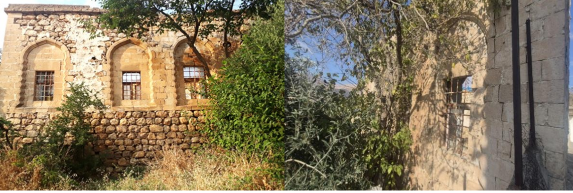
Şekil 14: Güney cephesi cephe sıva kaplanması (Karahana 2025)
