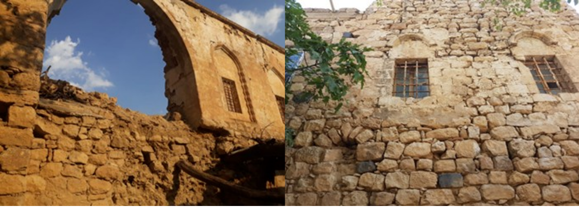
Şekil 11: Ahmet Karahan Evi batı cephesi (Karahana,2025)
