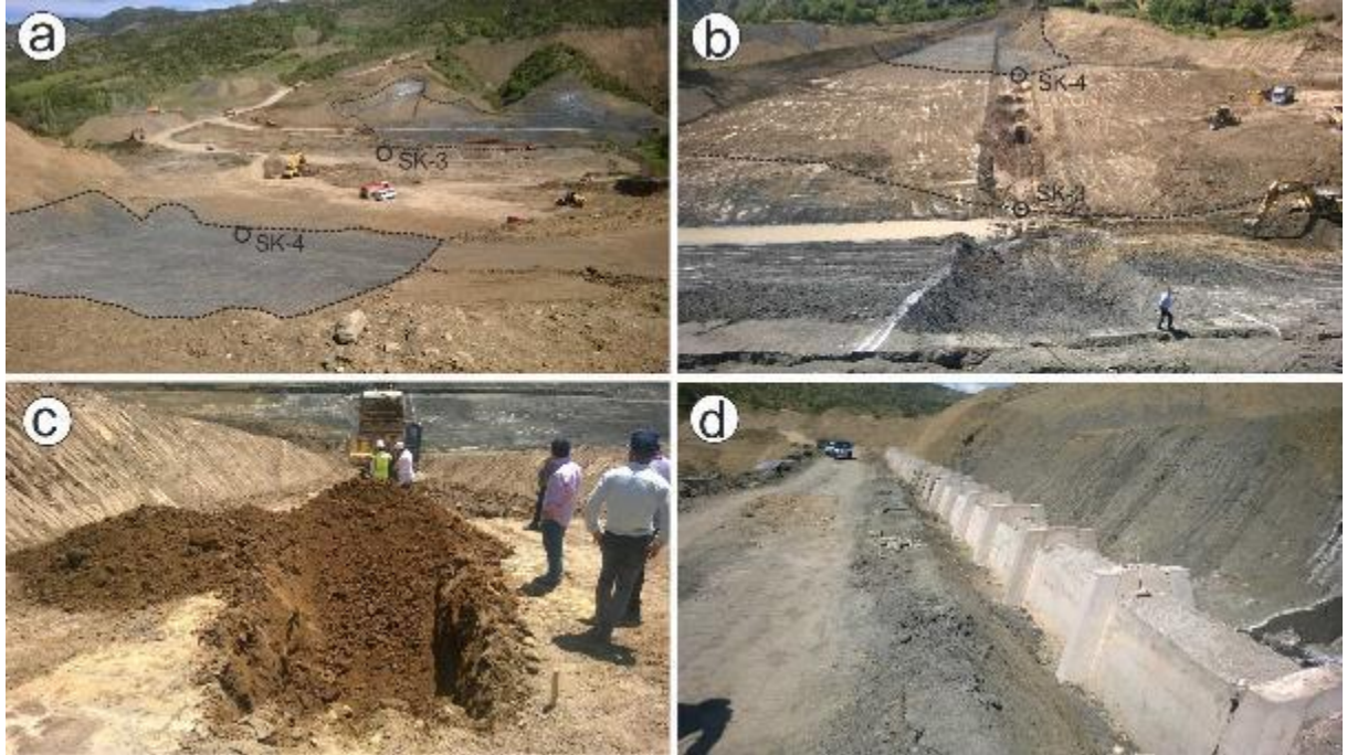
Şekil 11 - Derekargın göletinde SK-3 ile SK-4 kuyuları arasında kazılarak alınması gereken kahverengi gevşek zemine (Pliyosen) ve gövdenin oturacağı gri renkli sağlam kayaya (Eosen) sağ yamaçtan (a) ve sol yamaçtan (b) bakış, gevşek zeminin daha yakından görünüşü (c) ve sol yamaçta kondüvinin oturduğu sağlam Eosen kumtaşı-marn-silttaşı tabakaları (Foto: Hasan Deveci)
