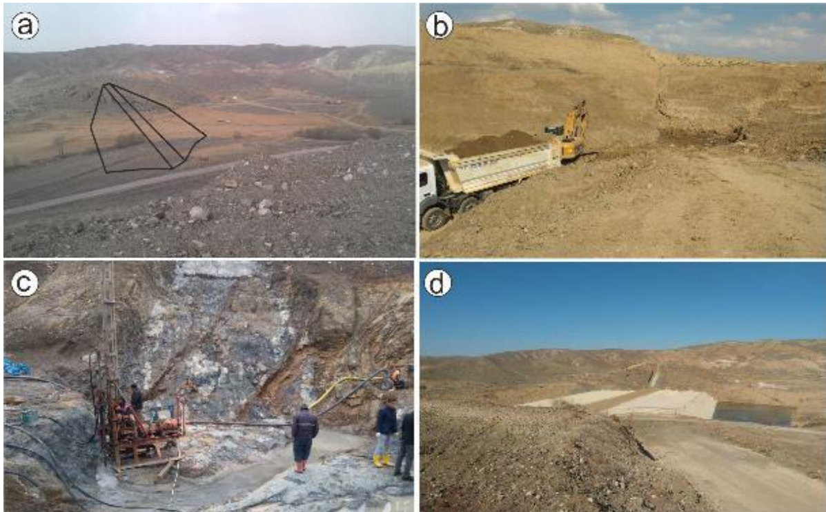
Şekil 5 - Sırçasaray göletine ait görüntüler (a: Gövdenin konumu, b: gövde altında sıyrılan alüvyon ve Eosen'e ait gevşek zemin, c: çekirdek hendeğinde sert ve sağlam çakıltaşları, d: gövde dolgu inşaatı devam ederken)
