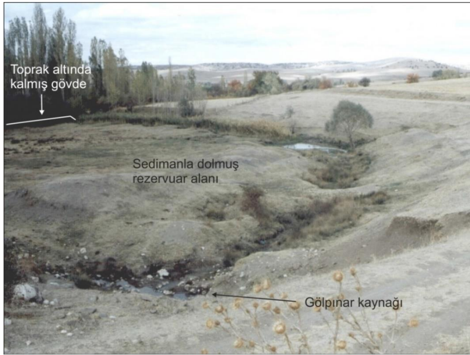
Şekil 4 - Hitit Barajının iyileştirme çalışmalarına başlamadan önceki hali [Orijinal foto:DSİ 2009]
