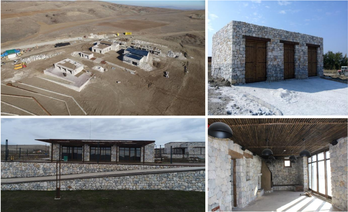
Şekil 17 - Hitit Barajı Rekreasyon Alanı ve Arkeopark Projesi kasamında inşa edilen yapılardan yakın görüntüler (Foto: DSİ 5. Bölge Müdürlüğü.ftp)
