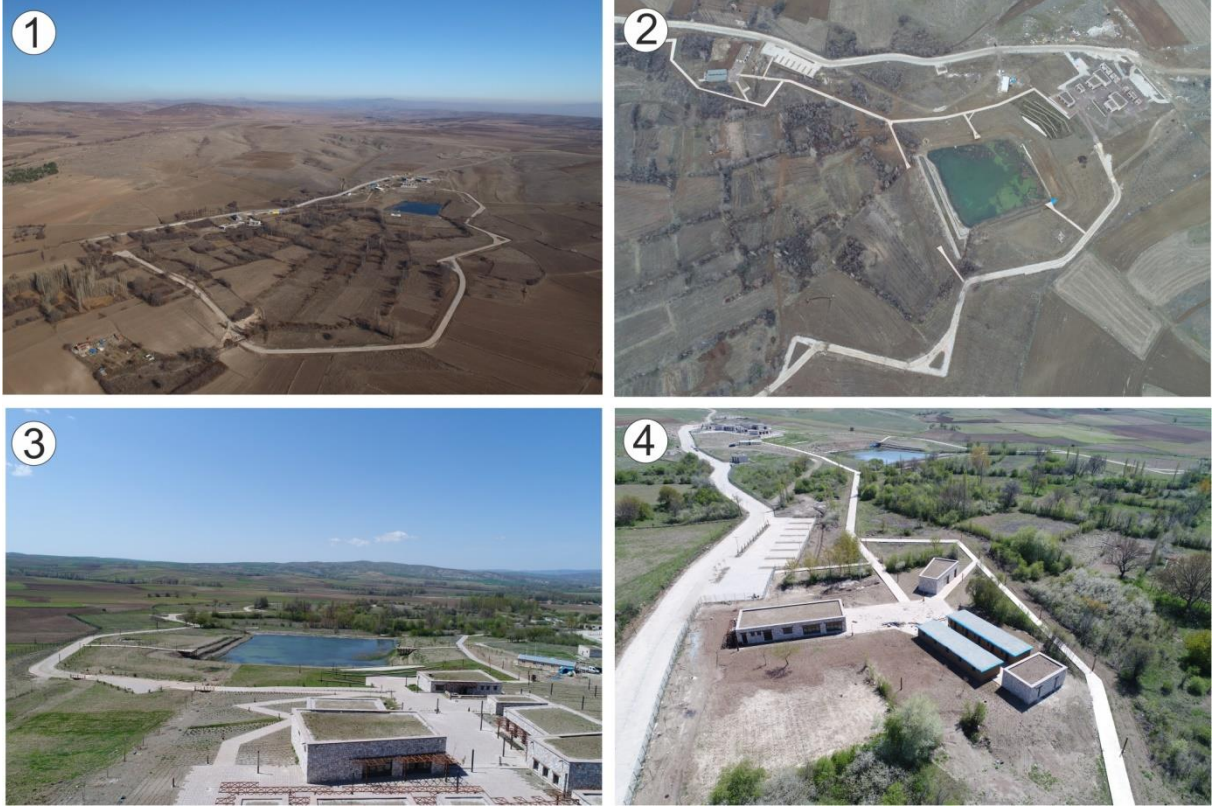
Şekil 16- Hitit Barajı Rekreasyon Alanı ve Arkeopark Projesi inşaatı ilerlerken çekilen görüntüler (Foto: DSİ 5. Bölge Müdürlüğü.ftp)
