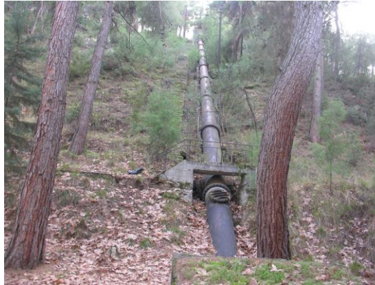
Ek 10. Gökpınar Hidroelektrik Santrali II (Cebri Borusu) (2018) (Fotoğraf yazar tarafından çekilmiştir (2018)).
