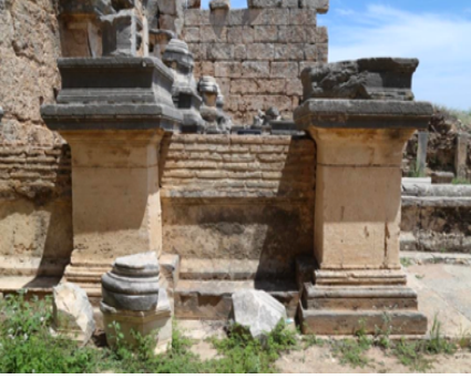
Fotoğraf 10. Perge, F3 Çeşmesi'nin havuz parapetleri üzerine Geç Antik Çağ'da eklenen tuğla duvarlar (Aksoy 2016, Şek. 3.7, B.19)
